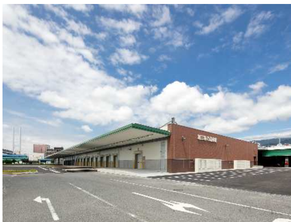
加工場・冷蔵庫棟
