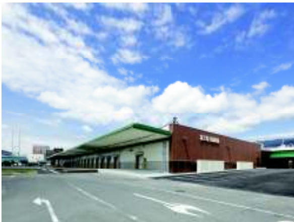
加工場・冷蔵庫棟
